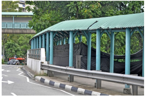
Eine ältere Variante, ebenfalls Singapur. Im Hintergrund eine Fußgängerbrücke, auch diese ist überdacht. Bilder von Juni 2019.
