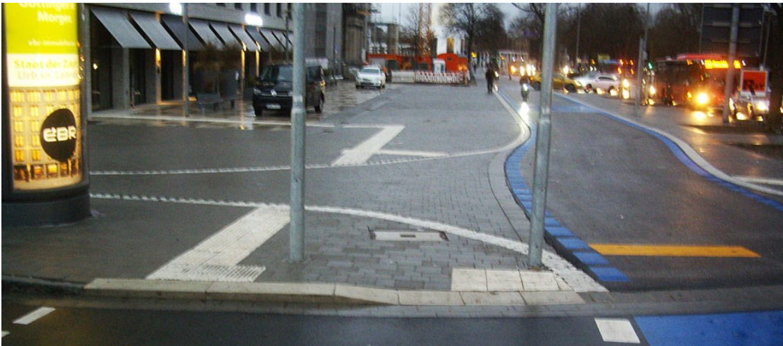
Foto 1. Sehr hoher 6 cm-Bordstein an der Nordseite, wurde in Göttingen noch nie in dieser Form verlegt. Er sollte durch 3 cm hohe abgerundete Borsteine ersetzt werden.
