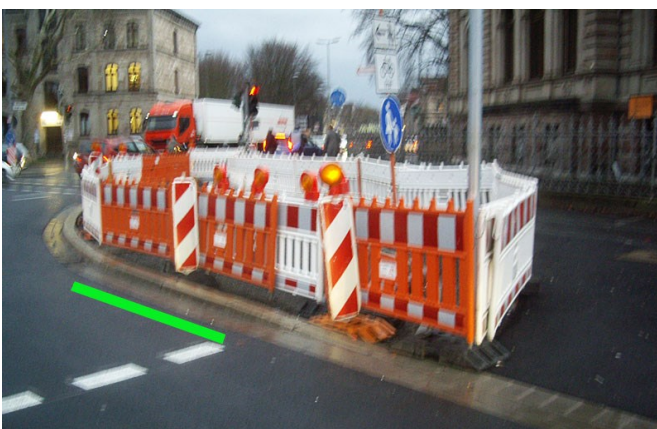
Foto 2. Südseitiger Übergang, derzeitige Baustelle. Der barrierefreie Übergang sollte um etwa 2 Meter (grüner Strich) nach Osten verbreitert werden.
