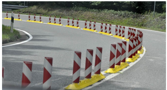
Fahrbahnteiler mit Leitschwellen und Leitbaken (Zeichen 605).
